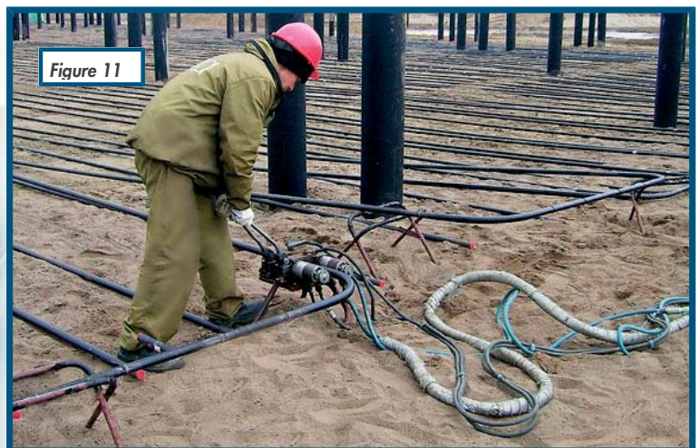
Figure 10: machine à souder MIAB mobile (Source: Institut de Soudage Paton)
