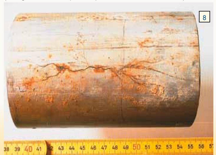
Figuur 8: geval van spanningscorrosie in een AISI 316 pijp door een combinatie van spanningen, chloride en temperatuur, optredend na enkele maanden diensttijd
