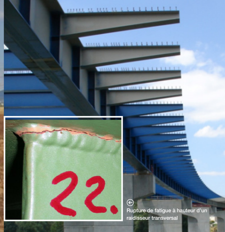
Pont autoroutier en acier en construction
