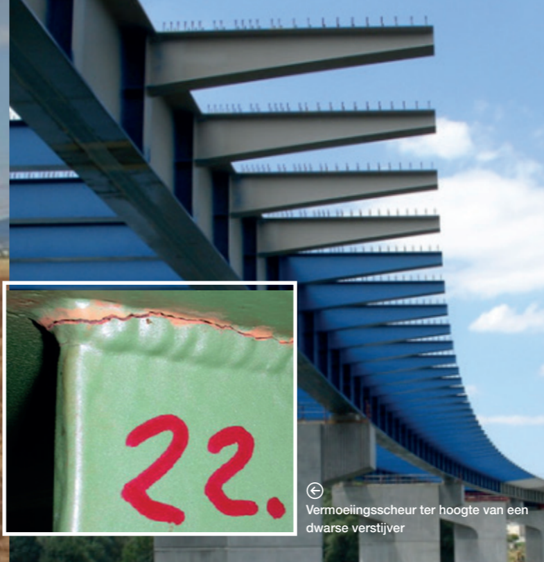
⬆ Stalen autowegbrug in opbouw
